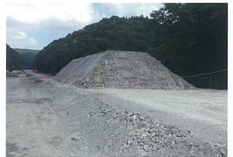
▲ 不溶化処理後のトンネル掘削土
